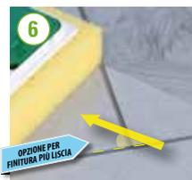
⑥ **Rifinitura con spugna in gommapiuma per una fuga più liscia:** per una finitura liscia, ultimare la pulizia con una spugna in gommapiuma con l'acqua della vaschetta ②, intervenendo in senso diagonale alle piastrelle per evitare di scavare le fughe.
